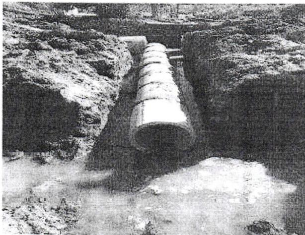
É óbvio que as alagações e cheias comprometem a estrutura da pavimentação que ficam imersas sem estar preparada e projetada para esta situação sem uma camada de drenagem abaixo da base. Outrossim, as cheias e alagações ainda ocasionam erosão no corpo de aterro dos bueiros, inclusive com queda de pista em um dos pontos visitados.
